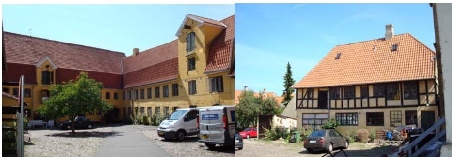
Figur 10 Den Voigtske Gaard og en dårligt vedligeholdt baggårdsbygning
