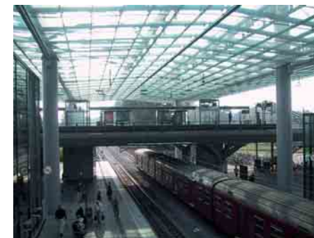
Overdækket tag, Flintholm Station, Kbh
