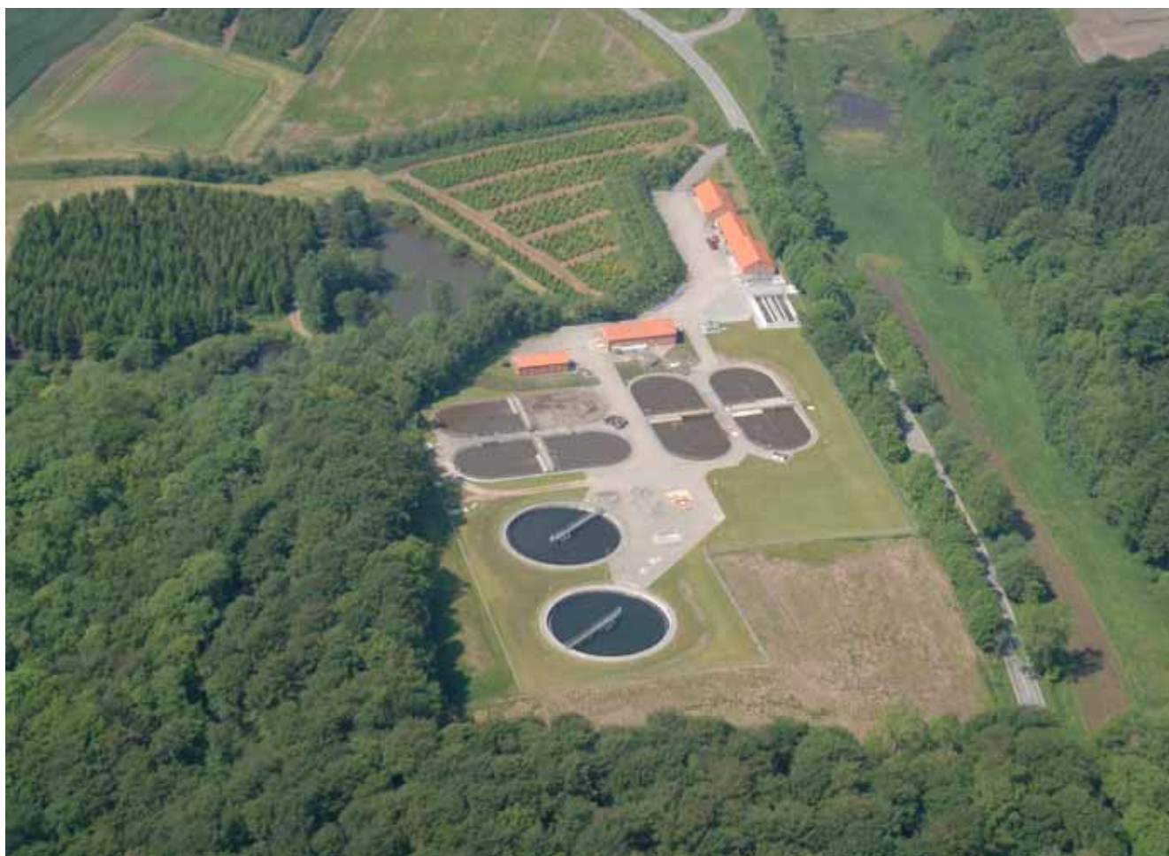
Centralrenseanlæg ved Daugård.
