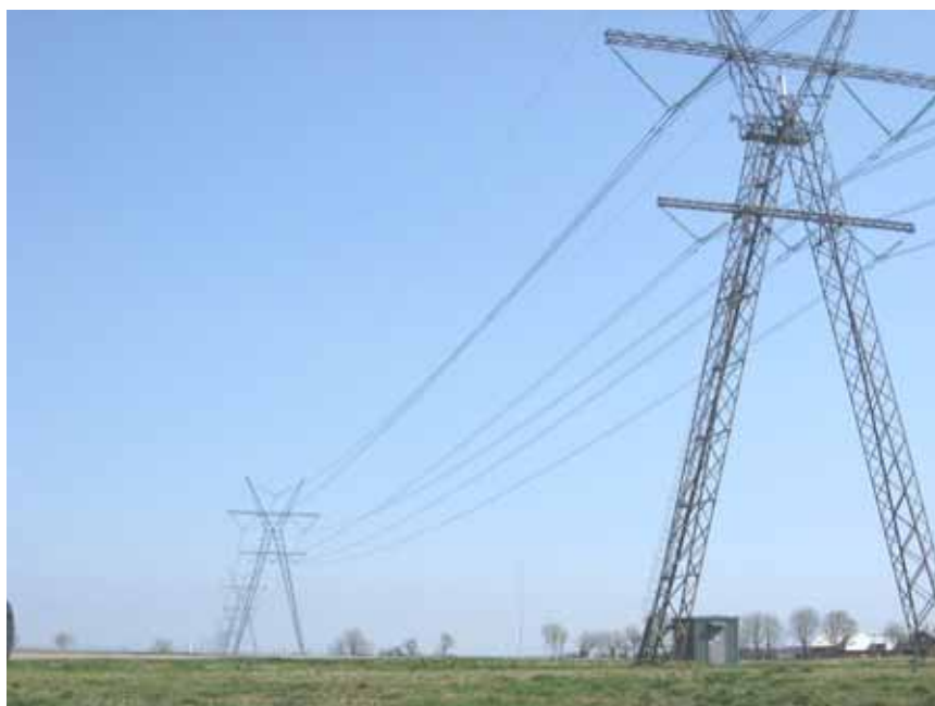
Højspændingsanlæg, nord for Lindved.
