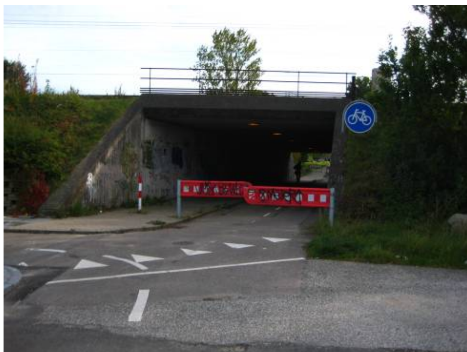
Billede: Tunnel ved Trekroner St. For at busser skal kunne passere denne vil det kræve at den laves mindst 1,5 m dybere og 2 m bredere.
