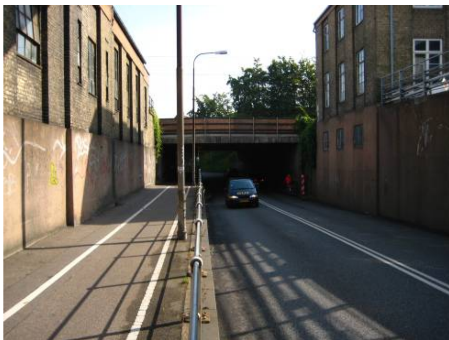
Billede: Viadukten set fra Jernbanegaderetningen. Tunnelvurderes at være for smal til 3 spor selv hvis cykel og gangstien til venstre nedlægges.
