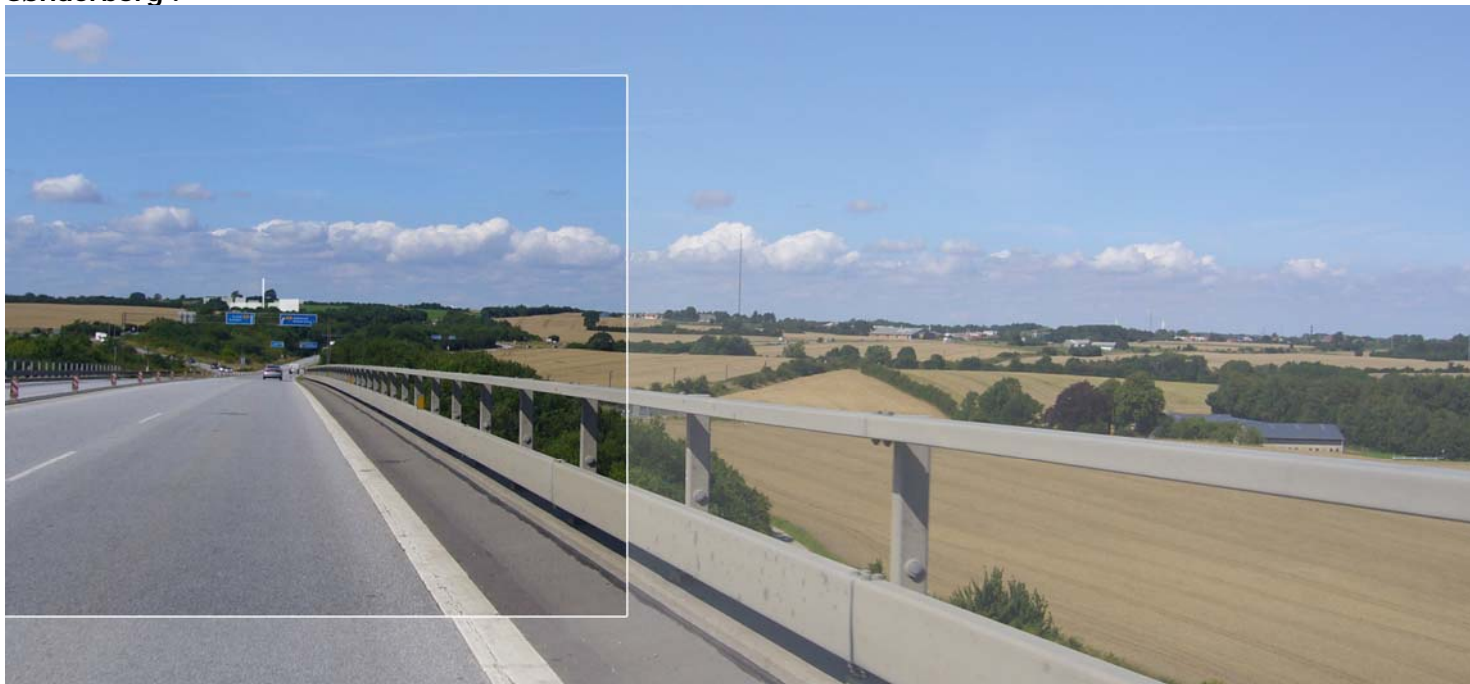
Fjernvirkning. Området set fra broen mod vest.
