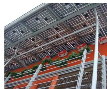
Detalje af udhæng solcelletag, Sonnenschiff, Vauban, Freiburg
