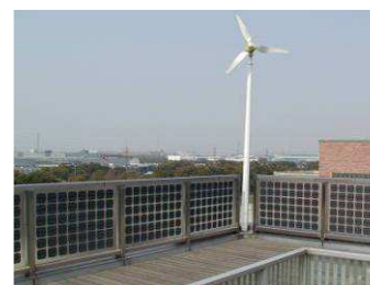
Lille vindmølle og solcellerækværk på taget af solcellefabrik, Shanghai
