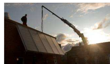
Sol, varmepumper, bølger mm 10%
