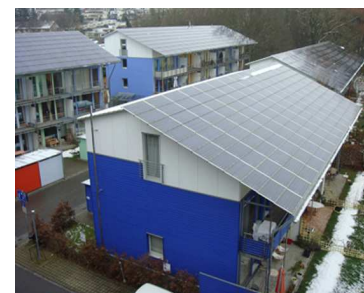
Sydvendt solcelletag, Solarsiedlung Sonnenschiff, Vauban, Freiburg
