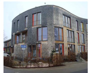
Boligbyggeri, Vauban Freiburg
