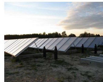
Solfangere på jord, Strandby Varmeværk, Frederikshavn
