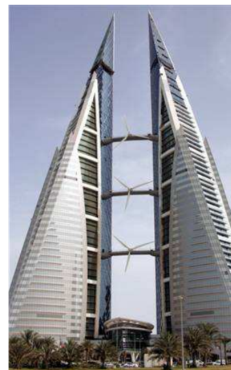
Tre vindmøller placeret mellem tårnene på Bahrain World Trade Center leverer op til 15% af centerets energibehov
