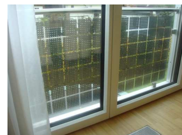
Solceller som altanbrøstning, passivhus, Hausen ved Stuttgart
