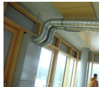
PCM isoleringsmateriale og infrarøde vinduespartier, Solarsiedlung Sonnenshiff, Freiburg
