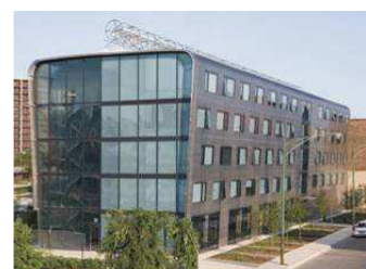
HAWT's (Horizontal Axis Wind Turbine) på bygningstag, Chicago
