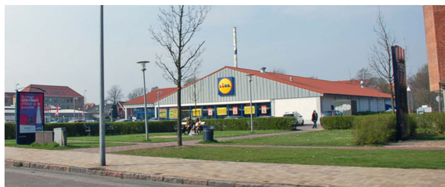
Bolbro-centeret har for svag facade mod Middelfartvej.
