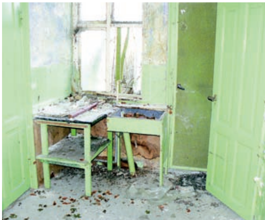
Landsbyernes dårlige boliger kan være sundhedsskadelige. I Lolland Kommune er planen at nedrive 40 -50 boliger årligt. Foto: Lolland Kommune
