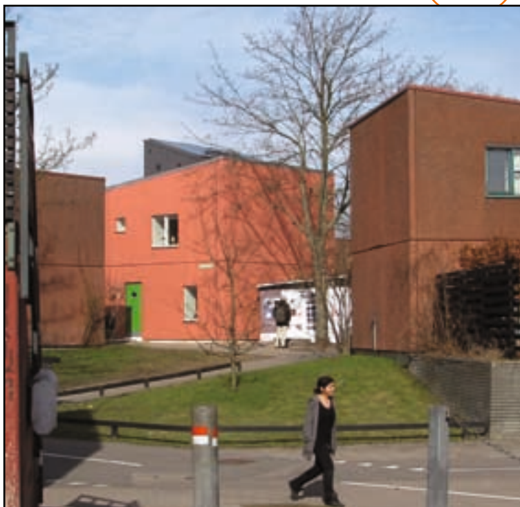
Rækkehuset i Hyldebjerg er forsynet med præfabrikerede væg- og tagelementer, solprisme, varmepumpe og vindmølle. Foto: Jakob Klint
