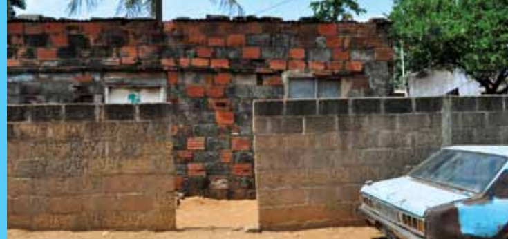
Mange huse bliver stående og forfalder før de bliver bygget færdig. Vinduer blokeres af forhåndenværende plademateriale eller mures til. Mursten og cementsten får mørke fugtpletter, og zinkpladerne på taget holdes på plads af cementsten. Foto: Silje Erøy Sollien
