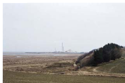
Skarresøerne med molerværk i baggrunden (KM3)
