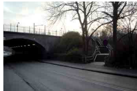
Viadukten med trappe til Banestien
