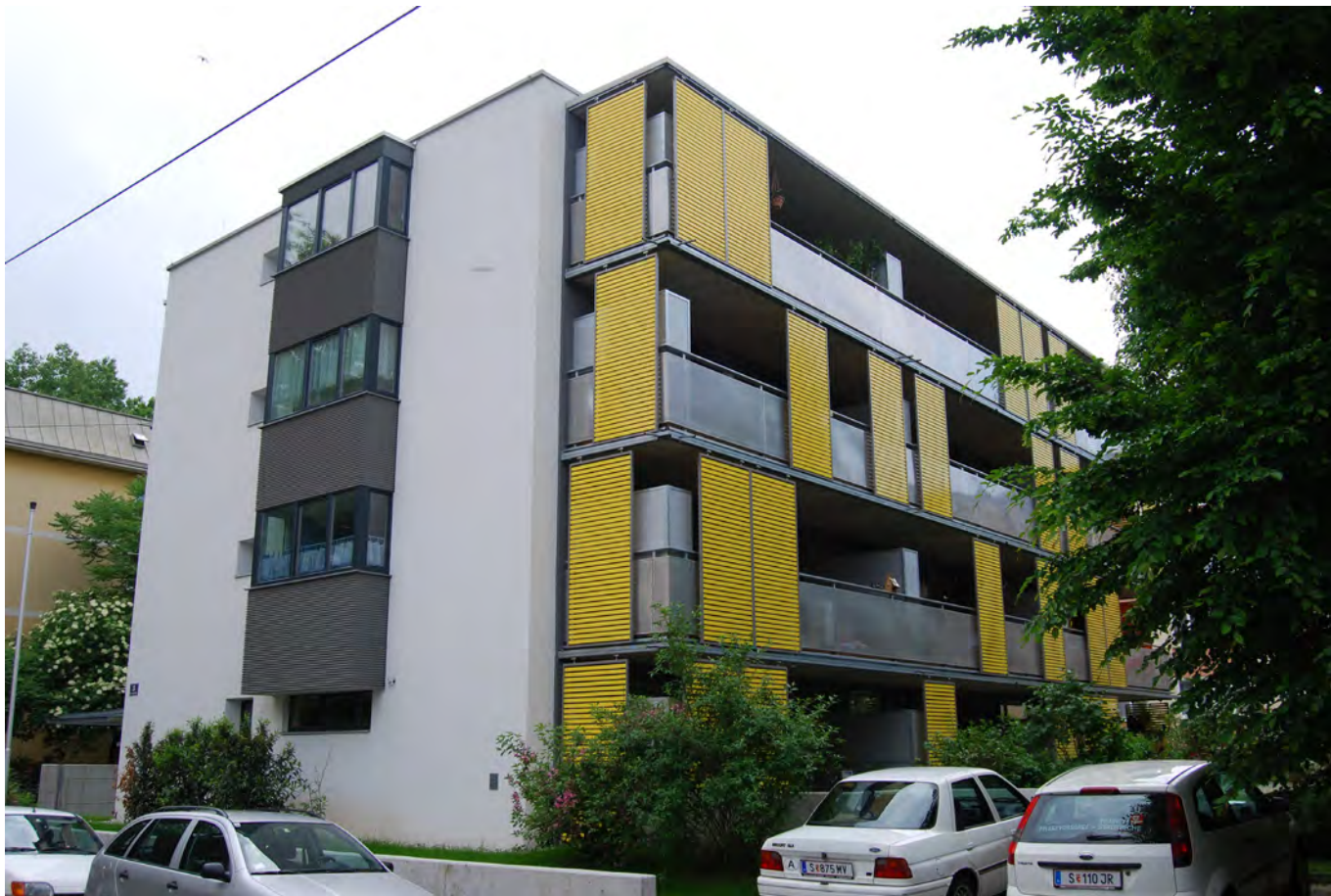
Passivhaus Esshaverstraße var det første gennemførte projekt under bydelens fornyelse.
