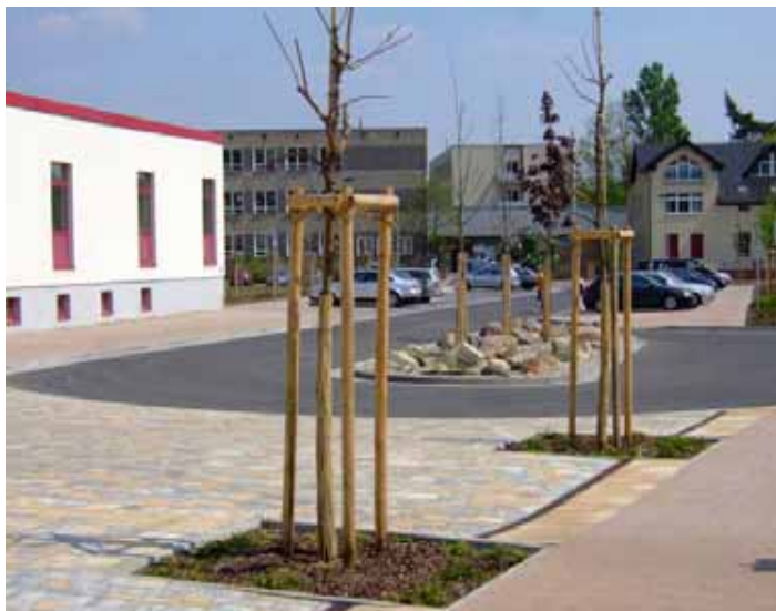
Fast belægning med opsamling af regnvand på p-arealer i byområder sikrer grundvandet mod bl.a. oliekomponenter.
