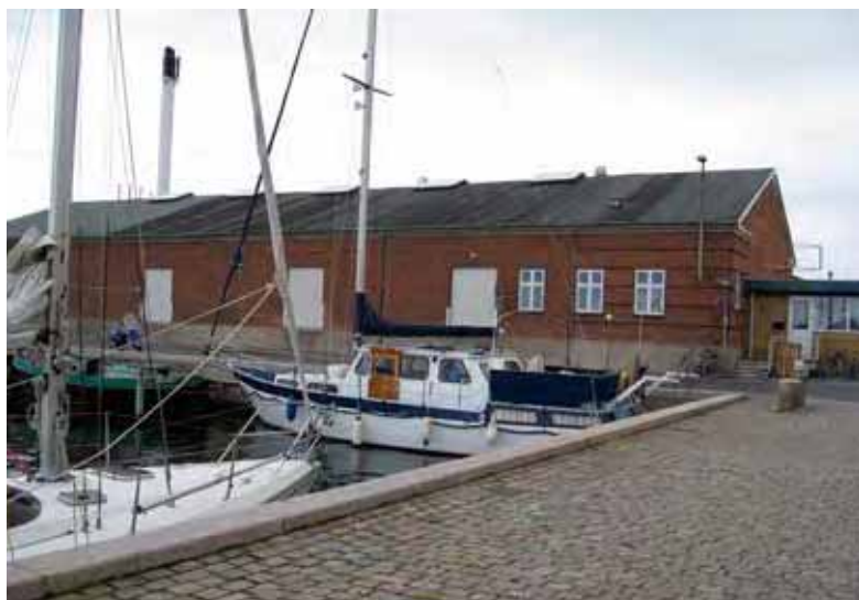
Den røde slagteribygning.
