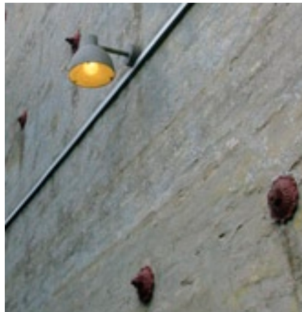
Spændebånd og betonpuds
