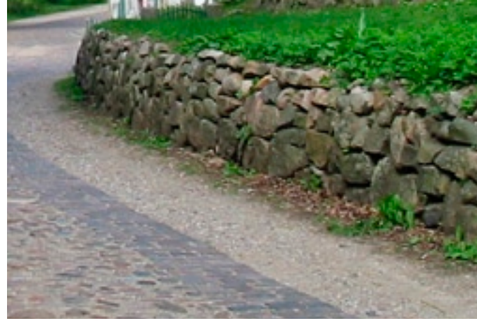
Stensætning og slidstærk belægning
