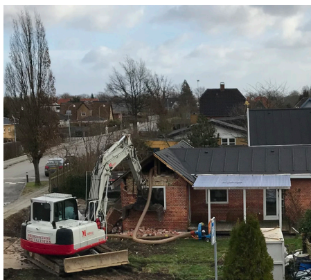
Billede: Nedrivningsprocessen i gang
