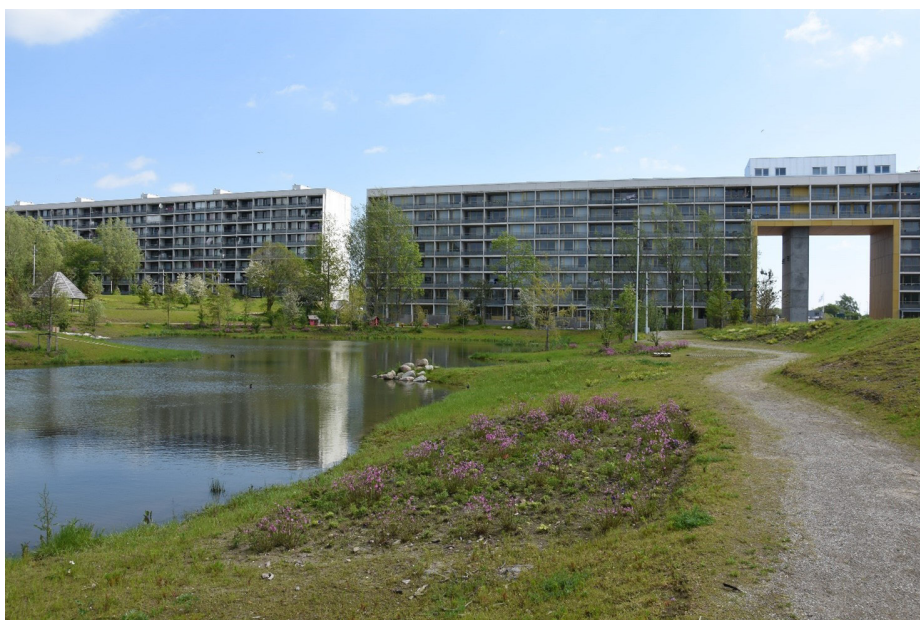
Figur: En renoveret boligblok i Gellerupparken. Med renoveringen af facaderne er der bygget videre på bærende arkitektoniske kvaliteter - samtidig med at et markant portrum fortæller en helt ny historie om Gellerup version 2.0 (Foto: Claus Bech-Danielsen).
