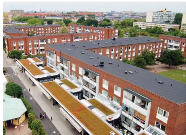
De såkaldte “Bokalerne” i boligbebyggelsen Rosengården, Malmø, er et godt eksempel på, at det klare skel mellem bolig og erhverv er nedbrudt ved at lave tilbygninger til eksisterende boligblokke med butikker og andre erhverv i umiddelbar tilknytning til en del af boligerne. Foto: MKB.
