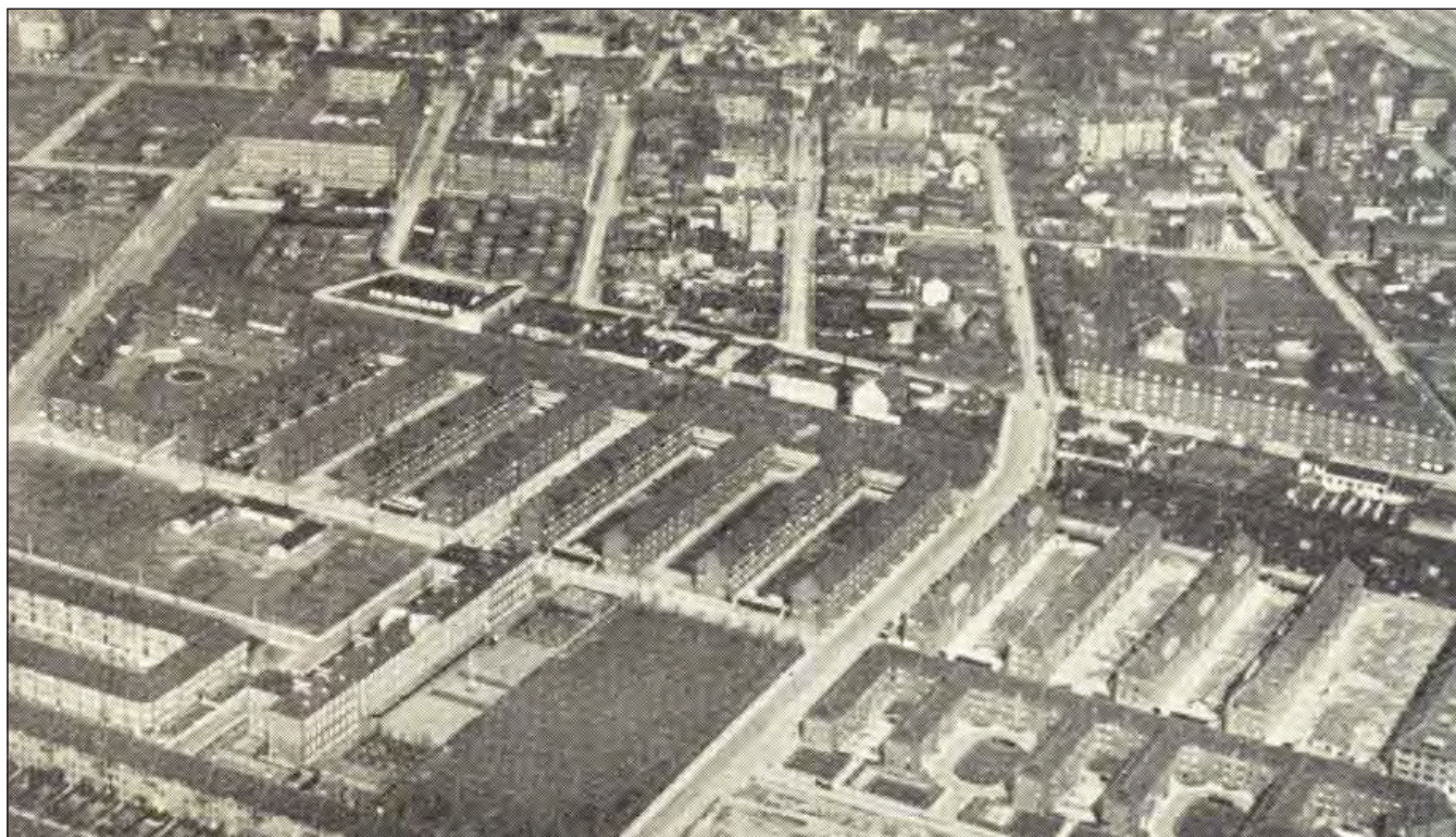
Nyere reguleret 3-Etages Forstadsbebyggelse med skole og sportsplads. Bygningshøjde ca. 10 m, Afsatnd mellem Husrækkerne ca. 20 m. Udnyttelsegrad omtrent som Frederiksborgloven (jvf. Afsn. X). I Baggrunden ses ældre, forvirret Forstadsbebyggelse. Dansk Byplanlaboratoriums Beretninger 1930 s. 30.
